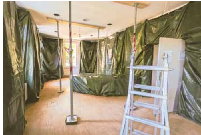
Die Bibliothek konnte saniert werden, ohne Bücher und Mobiliar vollständig zu entfernen.
