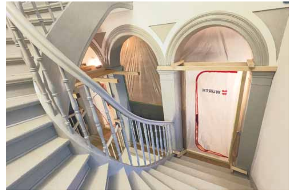
Der 1. Stock wurde während der Bauarbeiten so abgeschirmt, dass die Dauerausstellung im Erdgeschoss geöffnet bleiben konnte.
