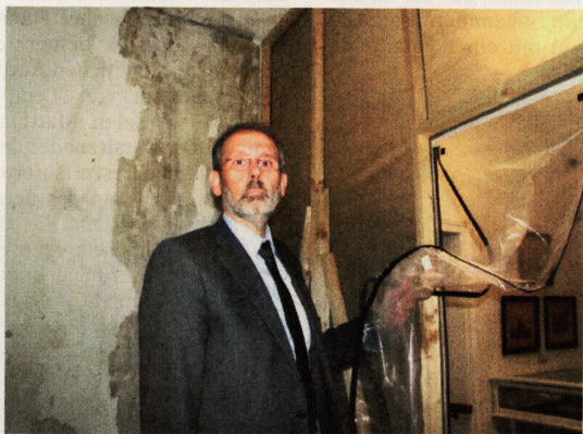
Dr. Ulrich Lappenküper zeigt Wasserschäden im Bismarck-Museum.
