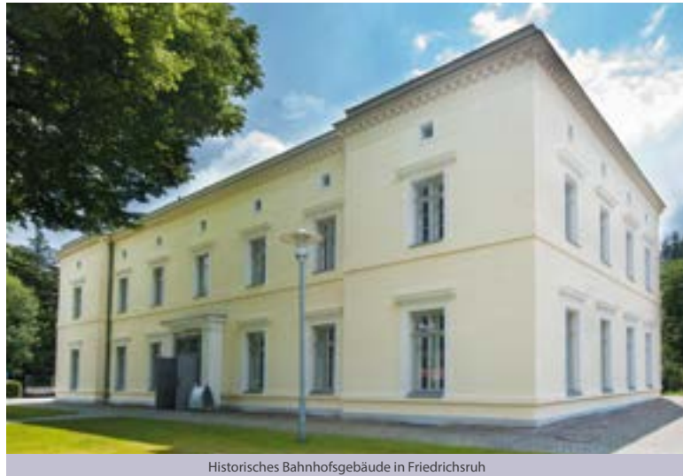
Historisches Bahnhofsgebäude in Friedrichsruh
